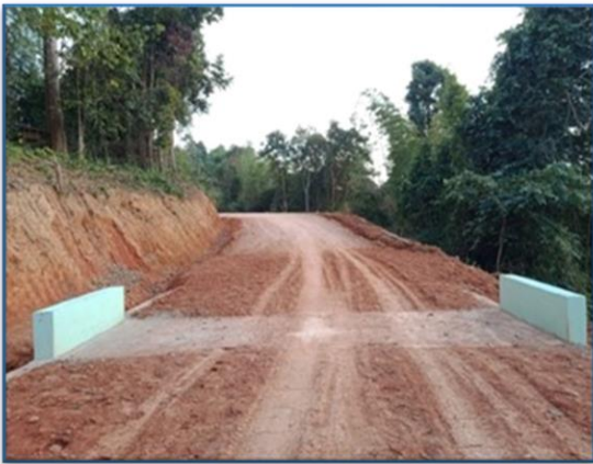
မိုင်းပျဉ်းမြို့နယ်၊ နားလန်းကျေးရွာ Box Culvert တည်ဆောက်ခြင်း
