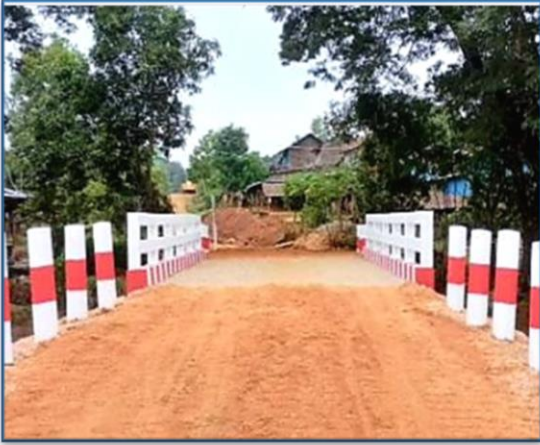
ရွှေတောင်မြို့နယ်၊ ကြို့ကုန်း-မဟာသိုက်ကျေးရွာ ကွန်ကရစ်တံတားတည်ဆောက်ခြင်း
