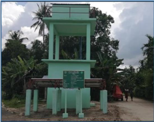
ဘားအံမြို့နယ်၊ မုက္ကဒိကျေးရွာ ဆိုလာရေပေးရေးစနစ်တည်ဆောက်ခြင်း
