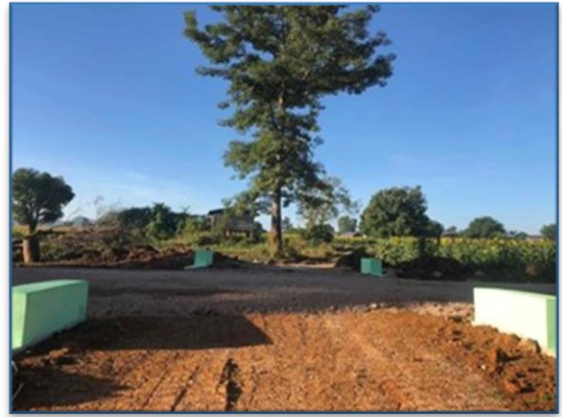
တောင်ကြီးမြို့နယ်၊ ဘန်ကွဲကျေးရွာ Pipe Culvert တည်ဆောက်ခြင်း
