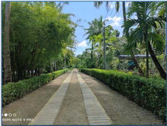
ကျိုတ်လတ်မြို့နယ်၊ အိမ်ယာကြီးကျေးရွာ ကွန်ကရစ်ဘီးလမ်းခင်းခြင်း
