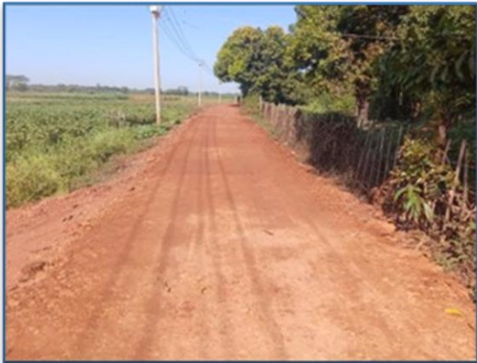
ရွှေကျင်မြို့နယ်၊ ထောင်လောင်ကျေးရွာ၊ ဂဝံလမ်းခင်းခြင်း
