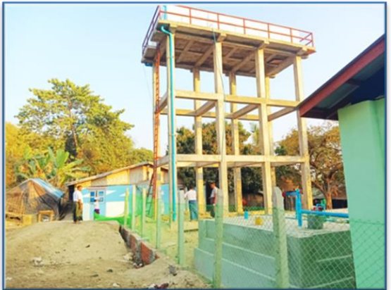
ကျောက်ဖြူမြို့နယ်၊ ကျောက်တလုံးကျေးရွာ အမြင့် ရေစင်၊ ရေစုကန်နှင့် ခြံစည်းရိုးဆောင်ရွက်ခြင်း
