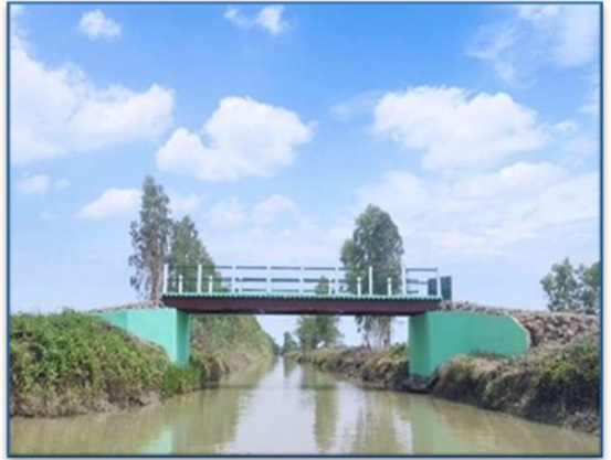
ဖျာပုံမြို့နယ်၊ ဂေးဂူကျေးရွာ ကွန်ကရစ်တံတားတည်ဆောက်ခြင်း
