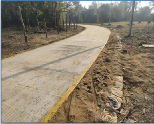
ရသေ့တောင်မြို့နယ်၊ ဘုရားလှကျေးရွာ ရွာတွင်း ကွန်ကရစ်လမ်းခင်းခြင်း
