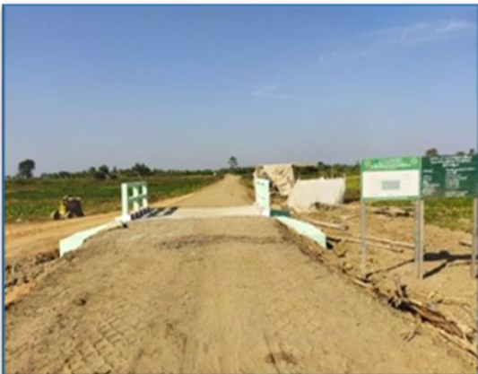
မြန်အောင်မြို့နယ်၊ ထိန်သေကြီးကျေးရွာ ကွန်ကရစ်တံတားတည်ဆောက်ခြင်း
