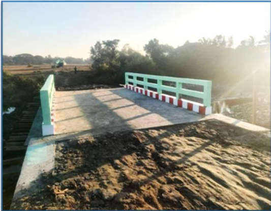
ရသေ့တောင်မြို့နယ်၊ ဘုရားလှကျေးရွာ ကွန်ကရစ်တံတား တည်ဆောက်ခြင်း
