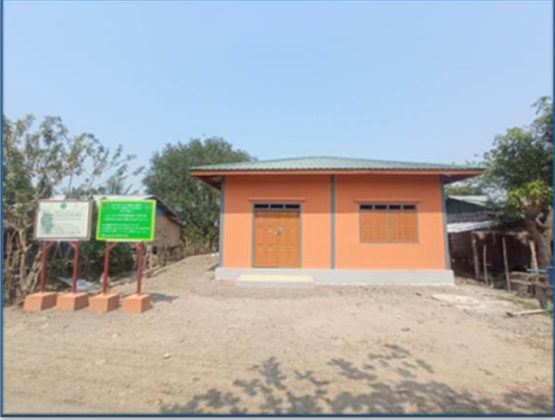
ပန်းတောင်းမြို့နယ်၊ ဒေါင်းတိုက်ကျေးရွာ ဘက်စုံသုံးခန်းမတည်ဆောက်ခြင်း
