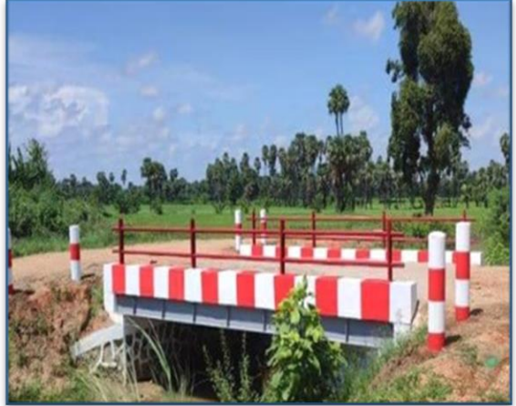
စလင်းမြို့နယ်၊ ပန်းပြင်ကျေးရွာ ကွန်ကရစ်တံတား တည်ဆောက်ခြင်း
