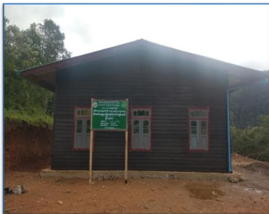
ဖယ်ခုံမြို့နယ်၊ ဆီဆောင်ကျေးရွာ မူကြိုကျောင်းတည်ဆောက်ခြင်း
