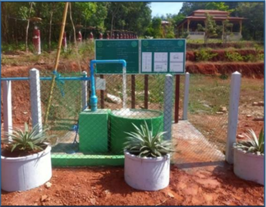
ရေဖြူမြို့နယ်၊ မင်းဒပ်ကျေးရွာ တွင်းတိမ် တူးဖော်ခြင်းနှင့်ရေစုကန်တည်ဆောက်ခြင်း
