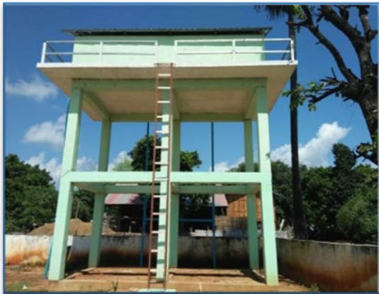
ချောက်မြို့နယ်၊ ပုပ္ဖကန်ကျေးရွာ အမြင့်ရေစင်တည်ဆောက်ခြင်း
